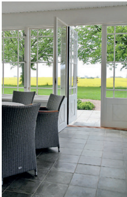
Dalles de béton traitées à la cire incolore à l'huile de lin.
