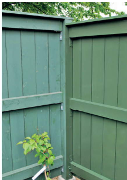
Première et deuxième couches. FINISSEZ DE PEINDRE ! Au moins 2 voire 3 couches.
