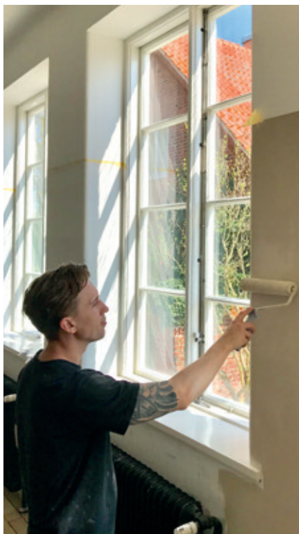
Utilisez la peinture Linus pour lisser et peindre. À appliquer au rouleau en perlon ou au pinceau. Apprêtez ou roulez avec Linus + poudre de ponce.
