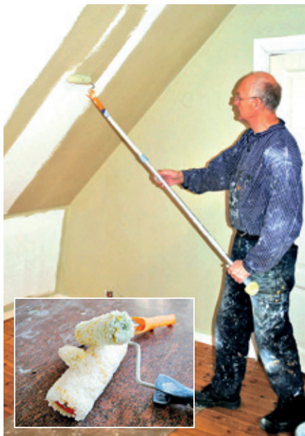
Application de Linus au rouleau en perlon sur papier peint. Attention ! Le rouleau doit rouler facilement !
