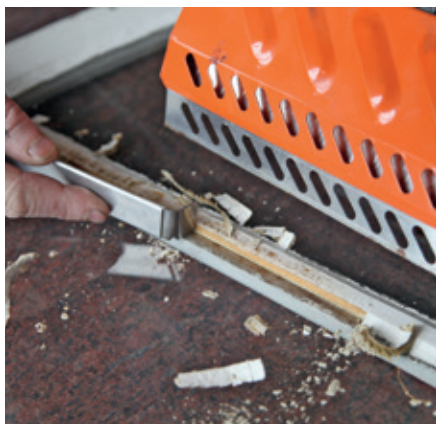
Lampe à mastic pour retirer le mastic. Elle peut également servir à décapier d'autres produits.
